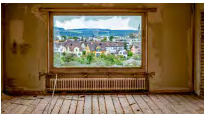
Fotodokumentation des Rückbaus (Markus Bauer)
